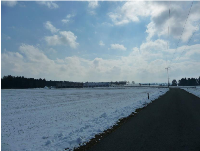
Abbildung: Blick von Westen nach Osten auf das bestehende bereits bebaute Gewerbegebiet „Gewerbepark C“
